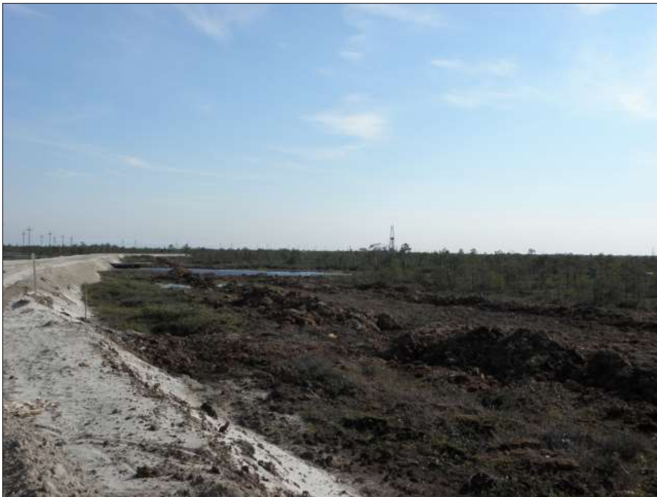
Рисунок 3. Дорога, нарушения придорожной зоны
